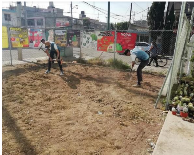
Figura 6. Preparación del terreno para la construcción del jardín botánico
